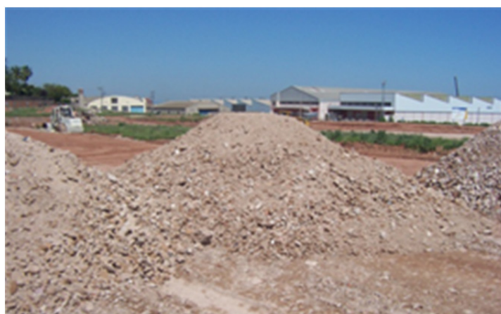
Figura 3. Acopio de AGR fracción 0-100 mm para uso en rellenos tipo terraplén.
